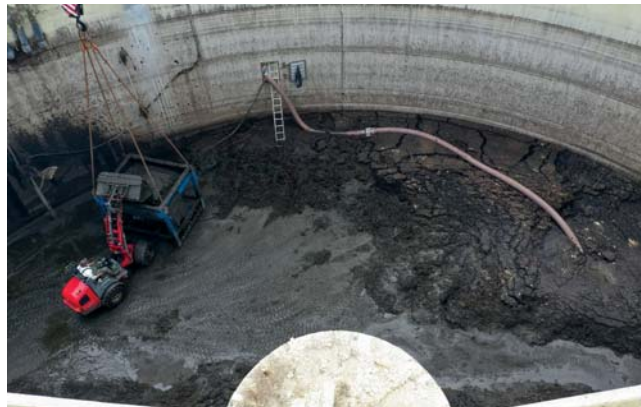
Baggerarbeiten in einer Biogasanlage – Stellt eine land- und forstwirtschaftliche Personengesellschaft Mitarbeiter an eine Biogasanlage ab, führt diese Tätigkeit zu gewerblichen Einkünften, die bei der Personengesellschaft zu einer Abfärbung führen. FOTO: CHRISTIAN MÜHLHAUSEN/LANDPIXEL.DE
